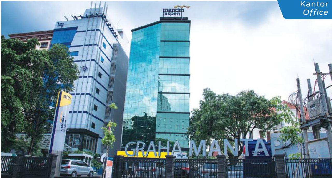
GEDUNG GRAHA MANDIRI TASPEN/GRAHA MANDIRI TASPEN BUILDING Jl. Cikini Raya No. 42 Kel. Cikini Kec. Menteng, Jakarta Pusat/Central Jakarta
