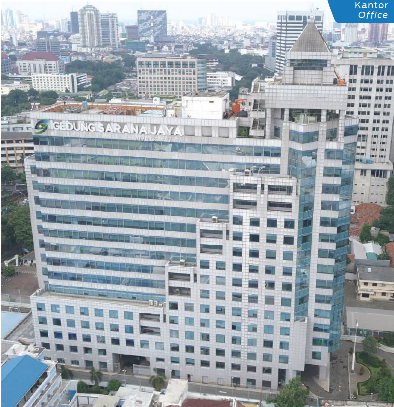
GEDUNG SARANA JAYA (KANTOR PUSAT SARANA JAYA) Jl. Budi Kemuliaan I No. 1 Kel. Gambir, Kec. Gambir Jakarta Pusat/Central Jakarta
