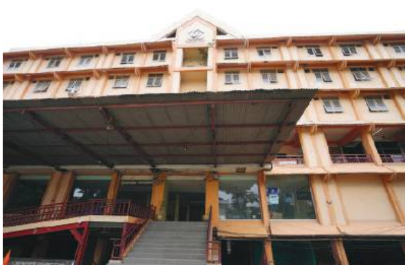
GEDUNG SARANA JAYA TEBET Tebet - Jakarta Selatan
